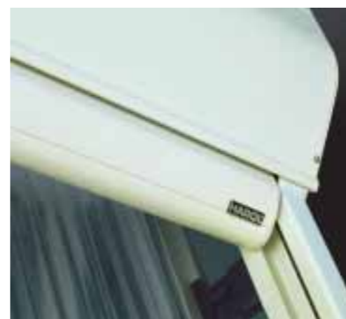
In opgerolde toestand bevindt de voorlijst zich deels in de kast, waardoor het doek beschermd wordt en het geheel tevens mooi oogt.
